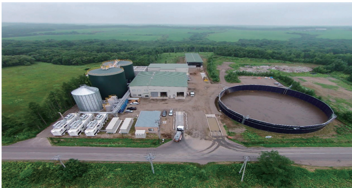
別海町バイオガスプラント（別海バイオガス発電株ホームページより）
